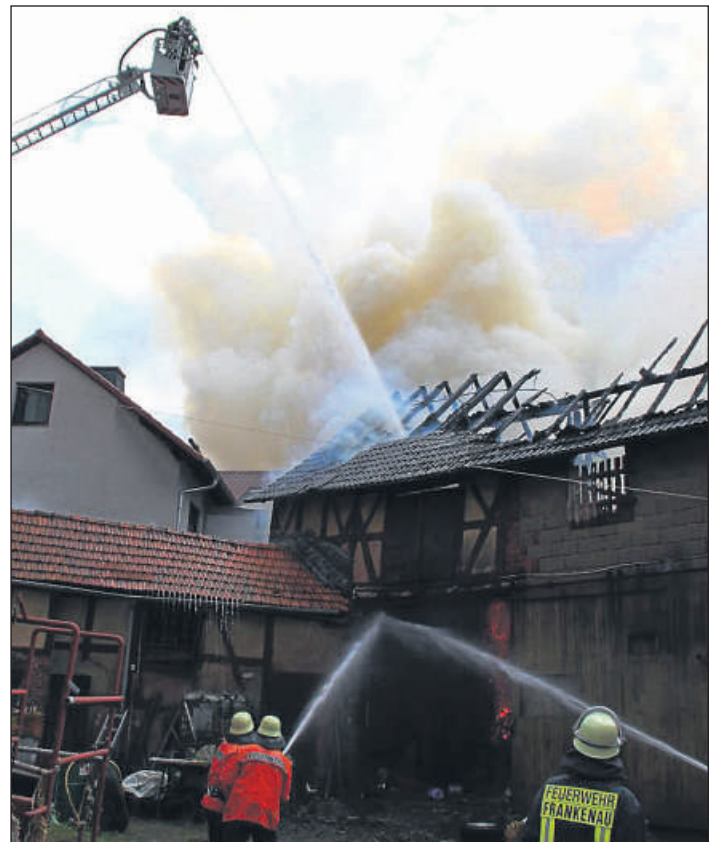
Vorderansicht: Auf diesem Bild wird deutlich, wie dicht angrenzende Gebäude neben der Scheune stehen.
